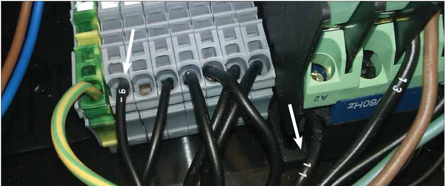
**Montage einer neuen Klemme (103821967) und Korrektur der Klemmennummer**
