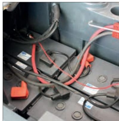
5. Laden und prüfen der Batterie.
